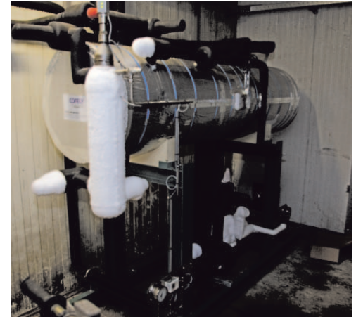
▲ Het voorraadvat met CO 2 moet constant gekoeld worden.
