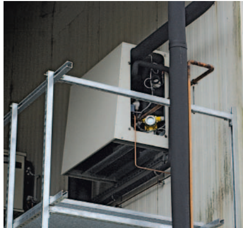
▲ De warmtewisselaar draagt de koude van het propaan over aan de CO 2 .
